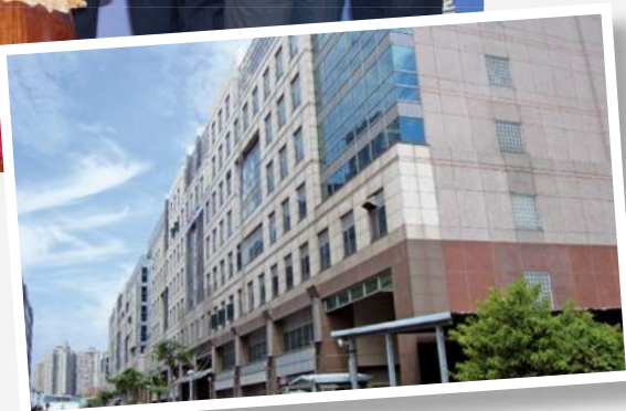
研揚科技大樓。
