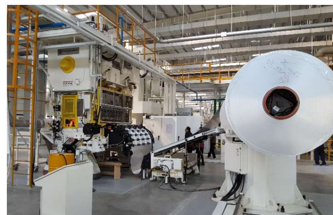
美國Stolle高速產線(鋁罐)
