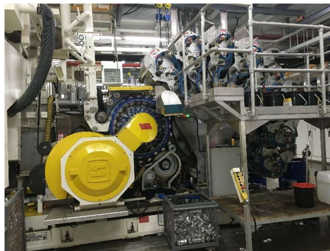
印刷與製罐產線
