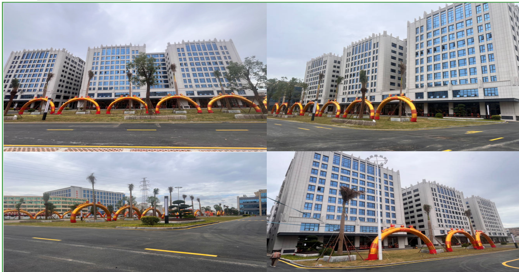
園區現場圖一
